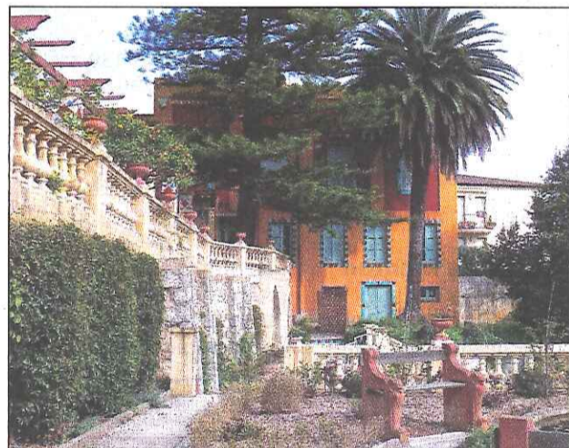
À la fin des travaux de restauration, la bibliothèque devrait accueillir le SIAP.
