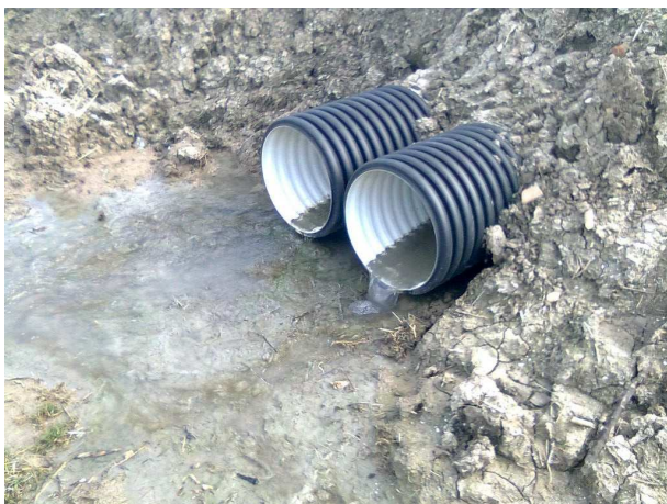
Conduites d'évacuation des eaux des terrains
