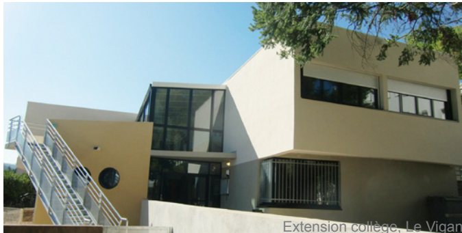
Extension collège, Le Vigan
