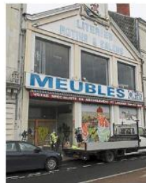
L'entrée principale de l'ancien magasin à été murée.
