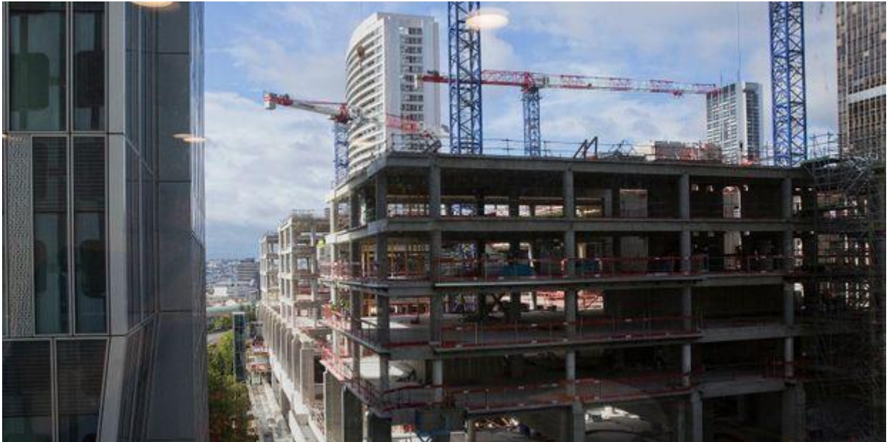
Un chantier de construction à La Défense, à Paris, en septembre 2022 (XFRANCOLON/SIPA)
