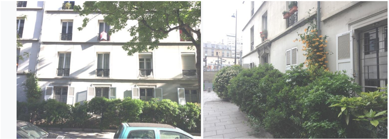
« Frontage » privé réalisé en 1990 devant l'immeuble du 4 cité de la Chapelle Paris 18 ème
