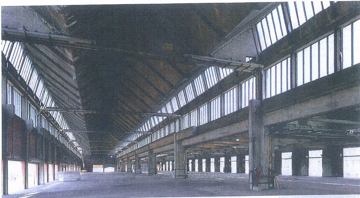
Le projet de La Chapelle Internationale, dans le XVIII e à Paris, a reçu son permis d'aménager. Les travaux de déconstruction ont commencé en juillet dernier.
