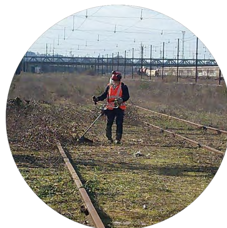
PRÉPARATION DU SOL
