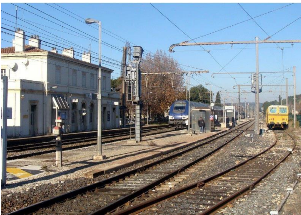
La gare de Rognac actuellement
