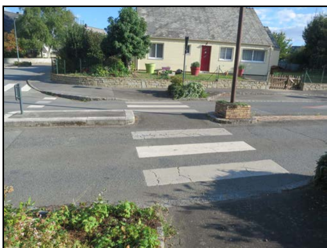
Abaissé de trottoir et îlot central (Chantepie)
