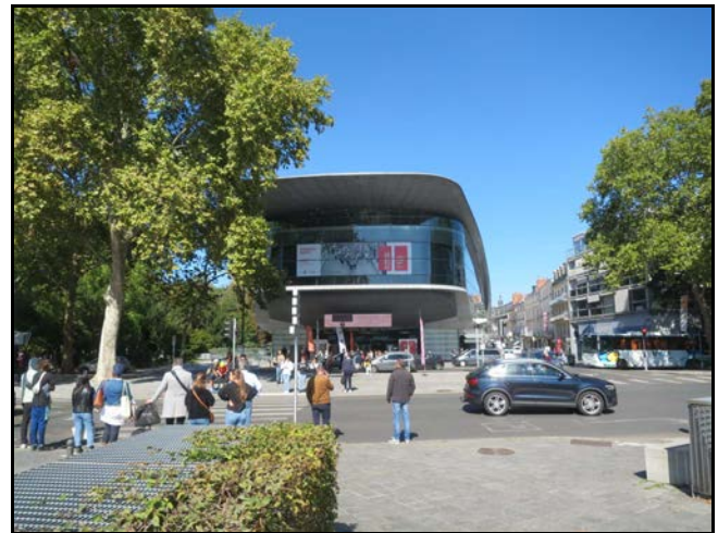
Palais des congrès, en face de la gare de Tours
