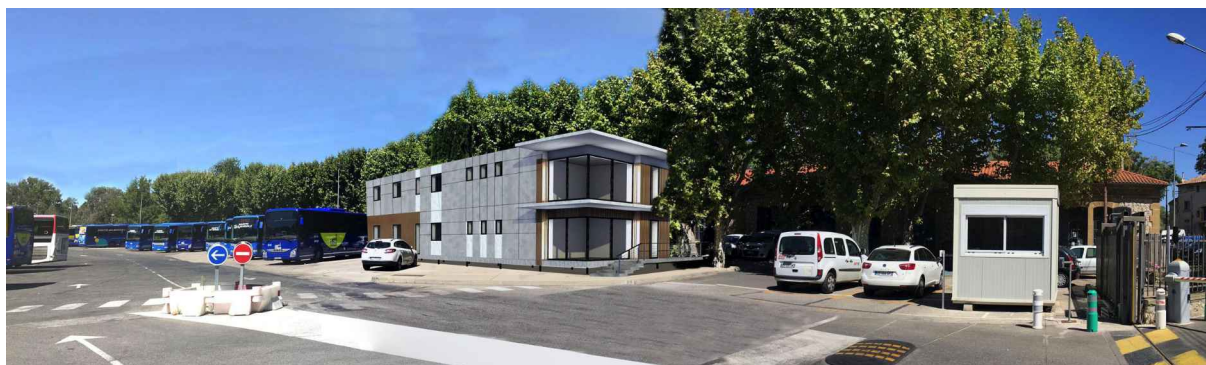
Photo n° 2 : Projet de nouveau centre d'exploitation en 2016
