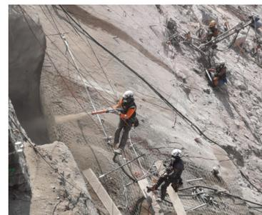
Béton projeté sur la paroi du mur à arcatures
