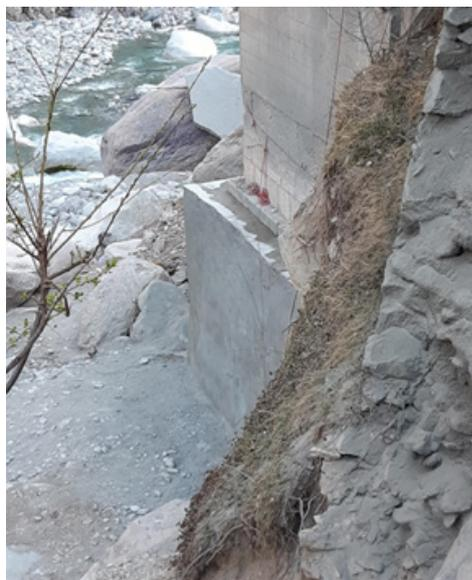
*Enrobage en béton réalisé sur les piliers du pont-rail de Tende*
