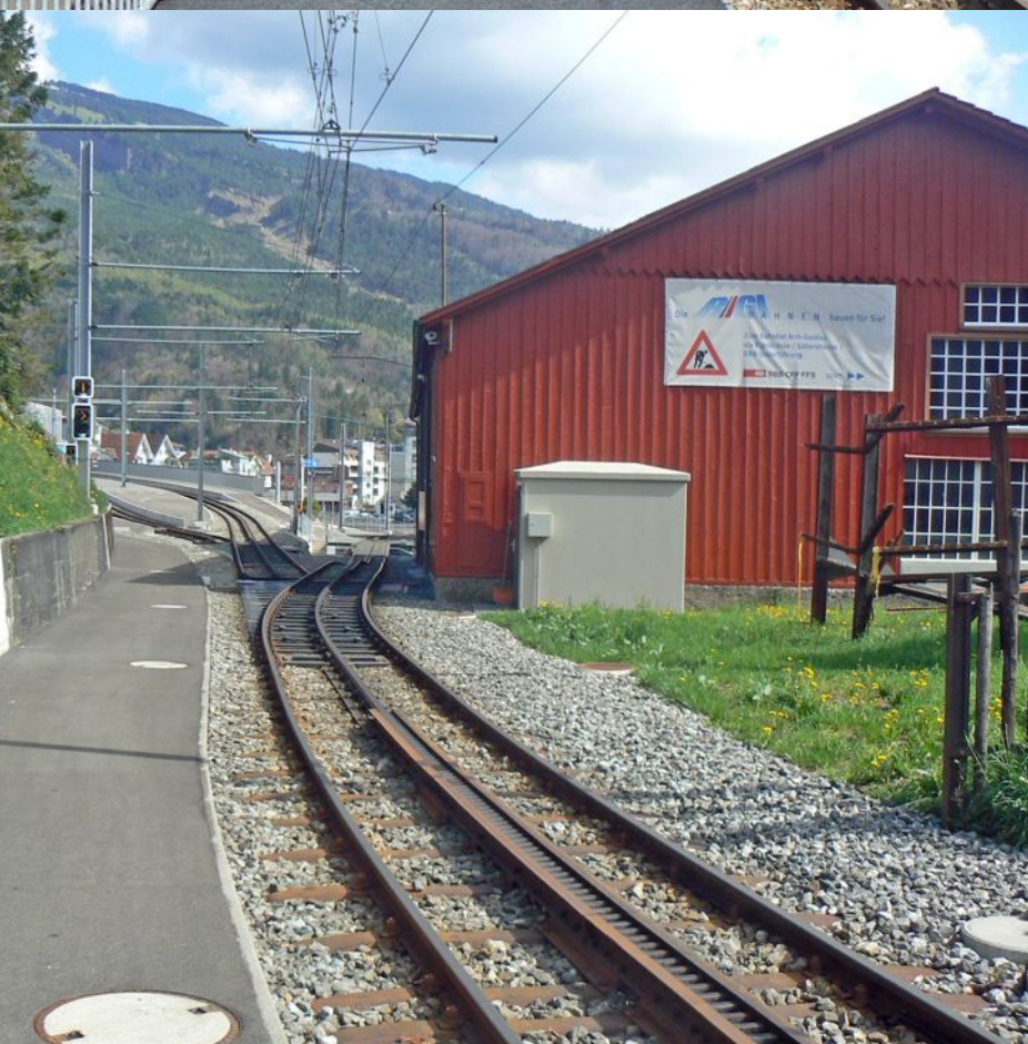
Ci-contre: l'entrée du dépôt avec un aiguillage flexible
