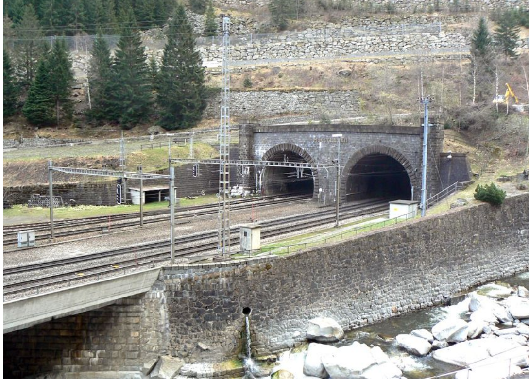
Göschenen l'entrée nord du tunnel du Saint-Gotthard
