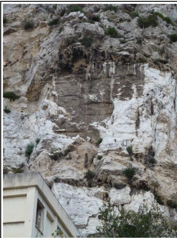
Photo 4 - Masse rocheuse en place (face)
