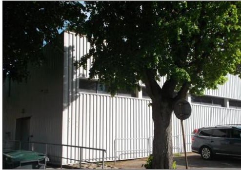
Après la restauration de l'intérieur du petit gymnase, c'est la rénovation de l'extérieur qui est maintenant proposée.
