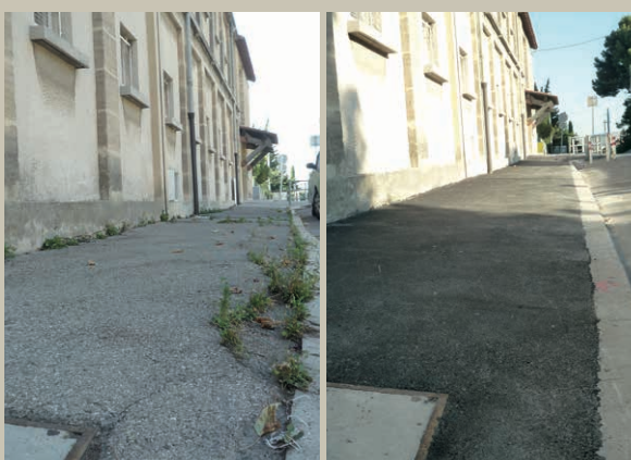
Rénovation du trottoir de l'école, boulevard de Bellevue - quartier les Borels (15 e )
