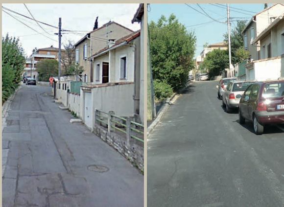
Réfection de la traverse de l'Américaine - quartier la Martine (15 e )
