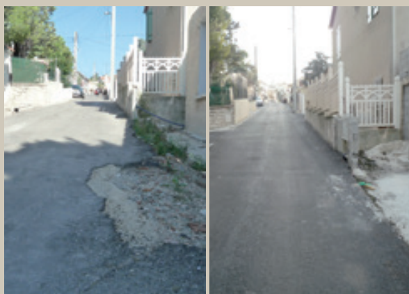
Réfection du boulevard du 7 e tirailleur Algérien - la Mure (15 e )
