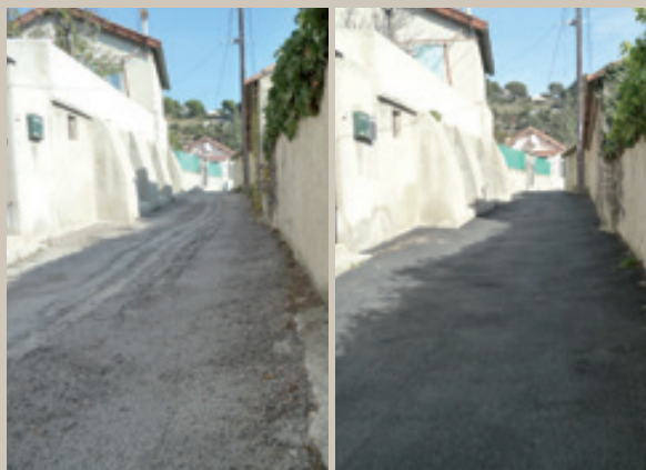
Réfection de l'impasse Puget Mitre - Hauts de l'Estaque (16 e )
