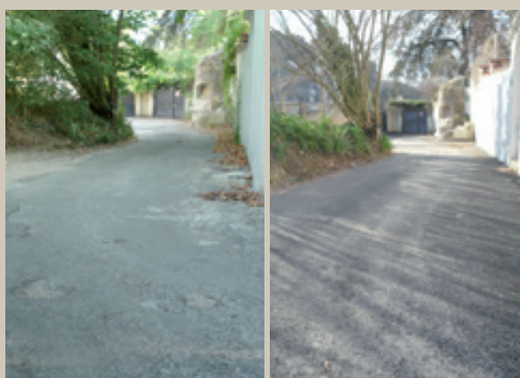
Réfection de la rue du Vallon - Palanque (15 e )
