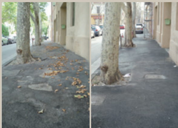
Réfection du boulevard d'Annam - Saint-Henri (16 e )
