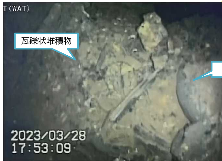
写真2.ペDESTAL内開口付近堆積物
