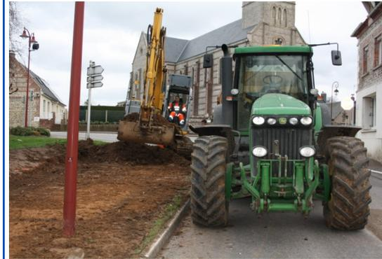
Les travaux de remplacement de la canalisation de tout-à-l'égout menés rue des Hirondelles, pris en charge par le syndicat des eaux pour un montant s'élevant à environ 100 000€, sont presque terminés. La route départementale a été consolidée et réparée. Il ne
