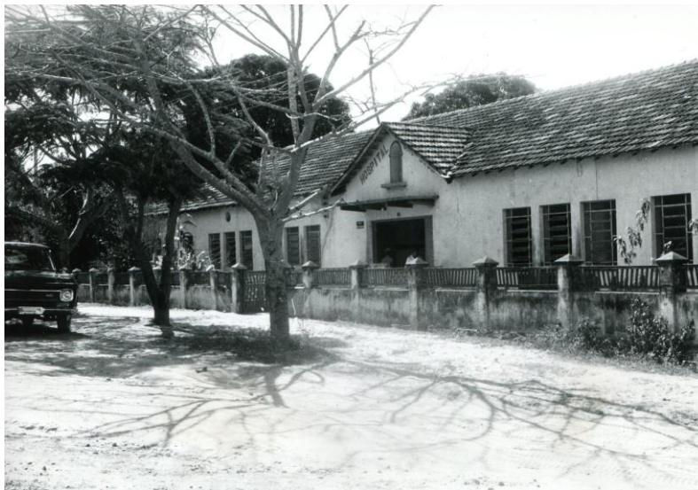
Obras: hospital de Balsas, 1974.
