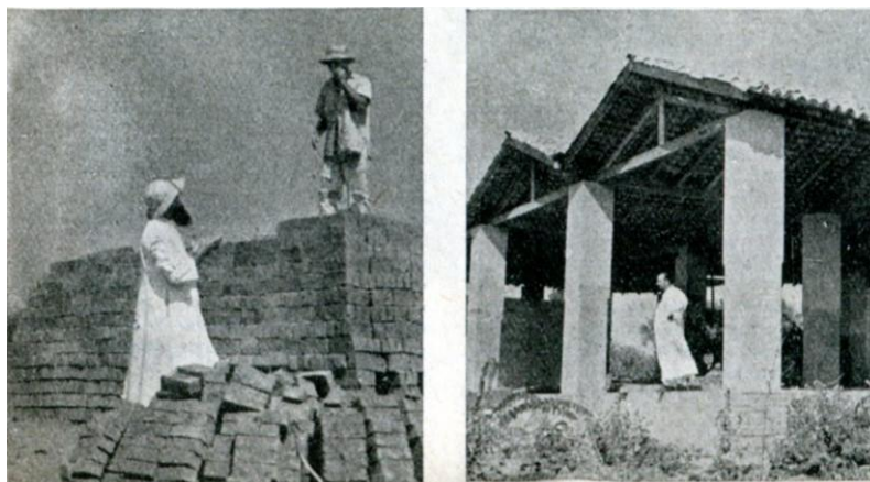
Construções em Balsas. Fonte: Balsas, Nigr. 1955-12, p. 4
