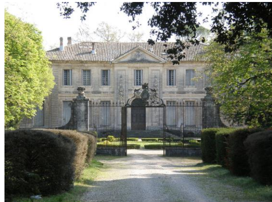
Château de la piscine
