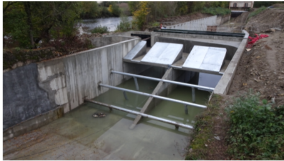
24/06 : Travaux UE Las Martres
