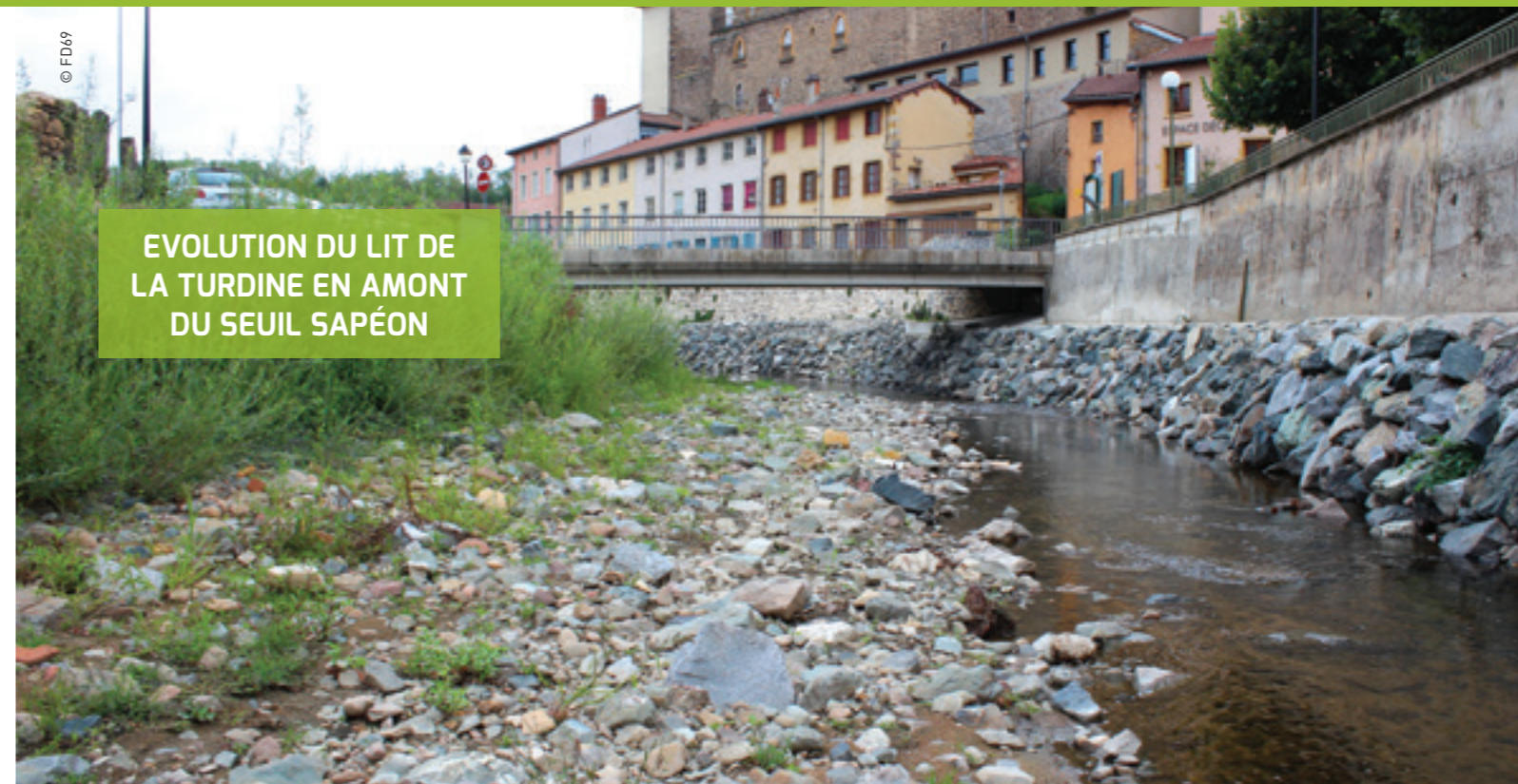
Après travaux (août 2018). La suppression du seuil atténue le risque d'inondation et redonne à la rivière sa clarté.
