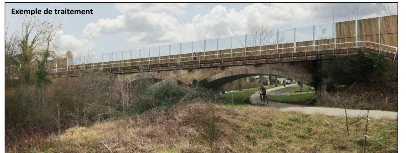
Mise en place de brises vues coté Salat pour maintenir le cadre naturel des berges du Salat et aménagement de passages sous le pont et d'une passerelle le long du pont, pour maintenir les circuits piétons et cyclables de promenade existants.
