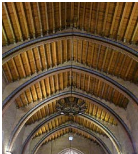
Vue générale de la charpente de l'église Saint-Etienne.
