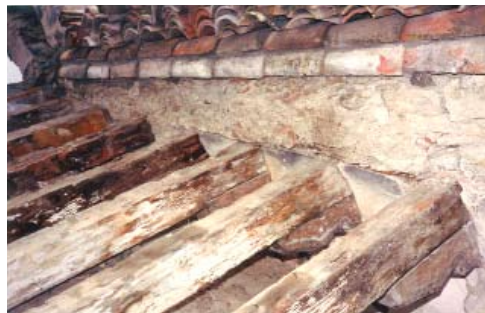
La charpente en place dans la travée de chœur. Cli- ché pris lors de la rénovation de la toiture (1989).
