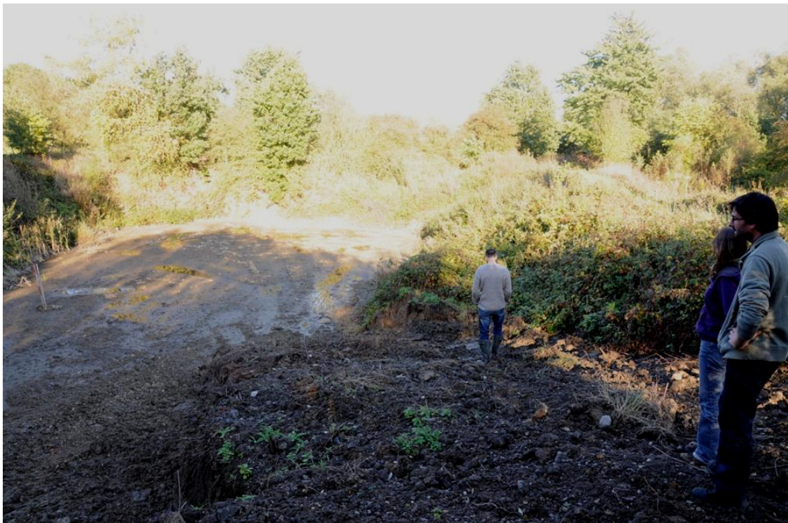
Figure 11 : Suppression de la connexion avec la Meuse et comblement partiel des argilières en 2011
