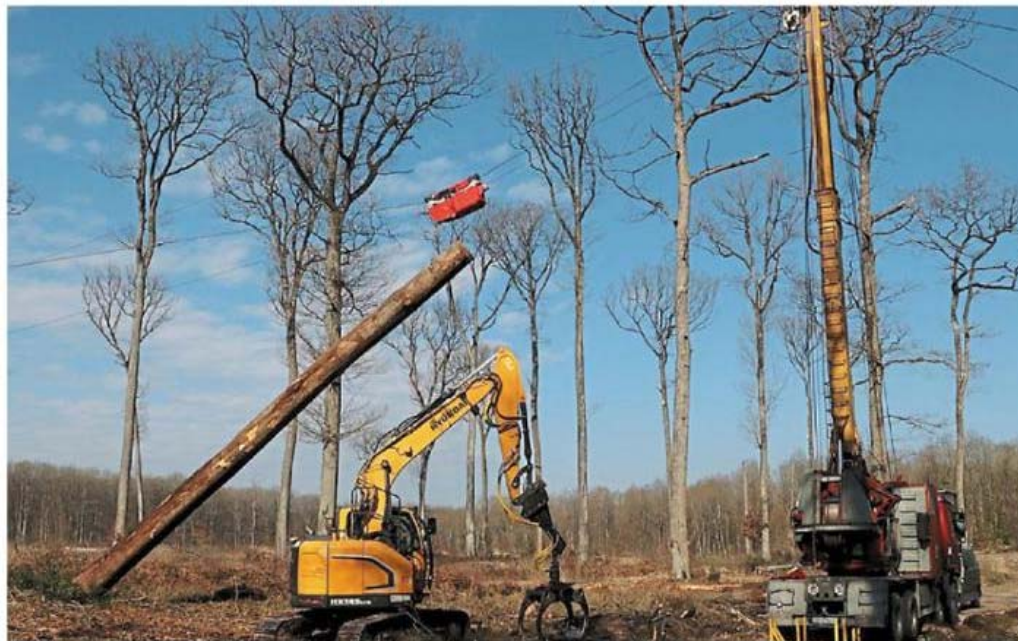
À Bercé, l'ONF teste le débardage par câble-mât.
