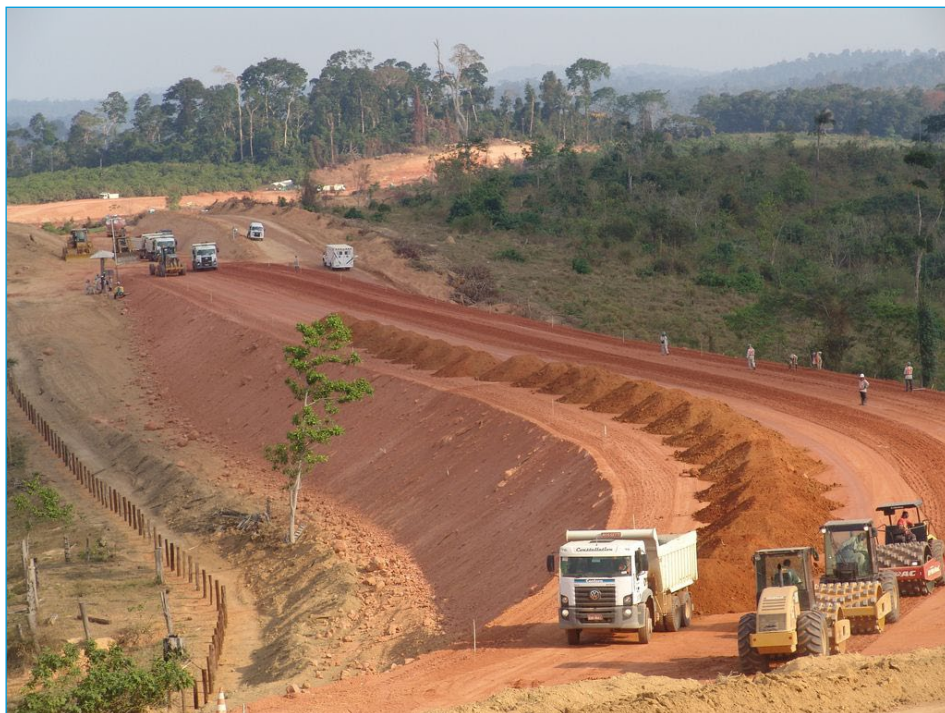
Wycinka lasów pod konstrukcję zapory Monte Belo (Brazylia)
