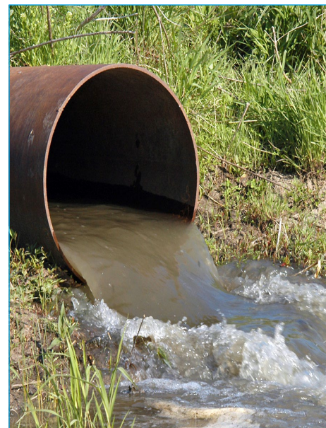
Ewakuacja wód ściekowych do jeziora
