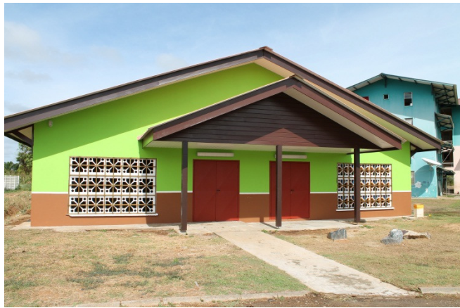
Maison de quartier Nobel (Kourou) réhabilitée sous forme de chantier d'insertion (ADSSUK)
