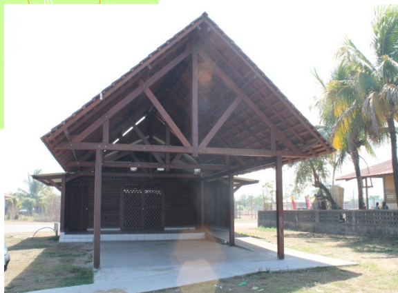
ACI Construction de carbet
