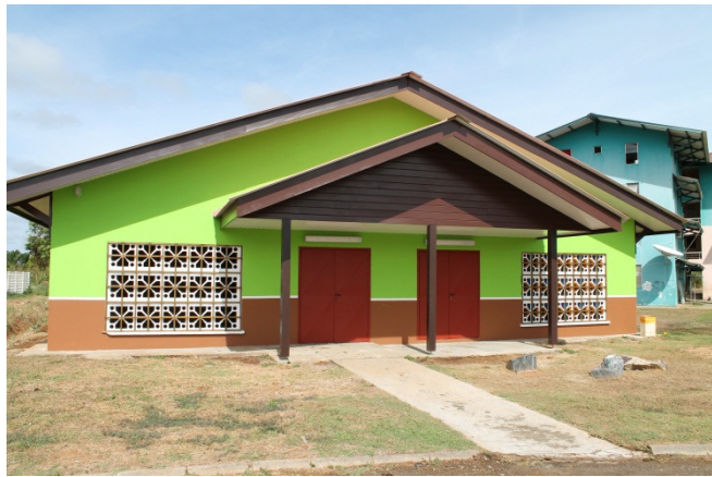
Maison de quartier Nobel (Kourou) réhabilitée sous forme de chantier d'insertion
