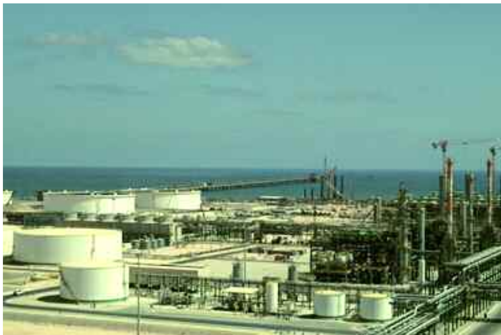
Western Libyan Gas Project: impianto di trattamento di Mellitah (© ENI).
