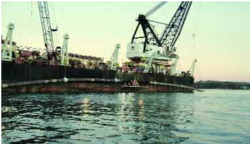
Operazioni di tie-in a Beni Saf — durante la costruzione del gasdotto Medgaz — a bordo della nave posatubi e sollevamento strutture della flotta Saipem CRAWLER (© Medgaz SA).
