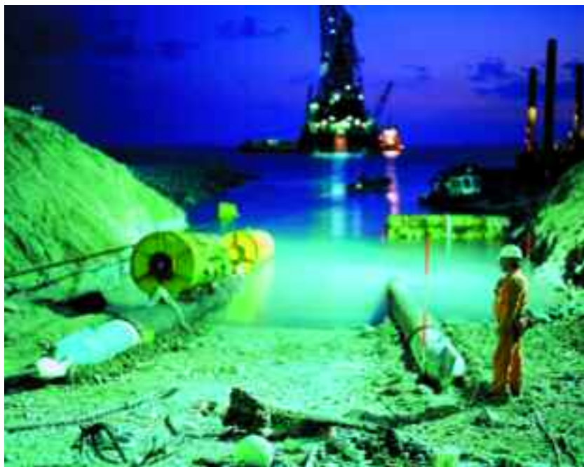
In alto: La nave d'appoggio POLAR PRINCE insieme a Innovator e Beluga (© Saipem). A lato: Blue Stream: supervisione delle ultime fasi dei tiri a riva a Dzhugba (© ENI).
