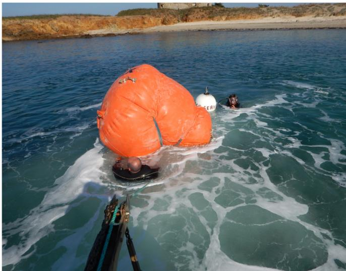
L'ensemble du mouillage (bouée, chaîne et corps mort d'un poids de près de 2 tonnes) tracté après avoir été décollé du fond par gonflage d'un ballon pour être repositionné.
