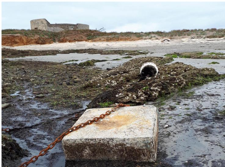
Mouillage constitué de sa bouée d'amarrage et de sa chaîne reliée au corps mort «échoué» sur la barrière rocheuse à plus de 200 m de son positionnement initial.
