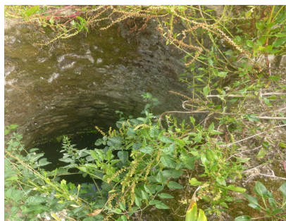
Béant et sans protection, l'orifice du puits à ciel ouvert présentait un réel danger
