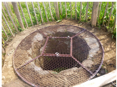
Ceinte de ganivelles, la tête de puits a été reconstituée et protégée par une grille.
