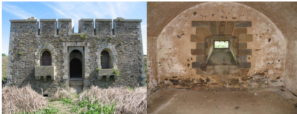
Le fort carré comporte trois niveaux dont deux, couverts, sous la terrasse d'artillerie
