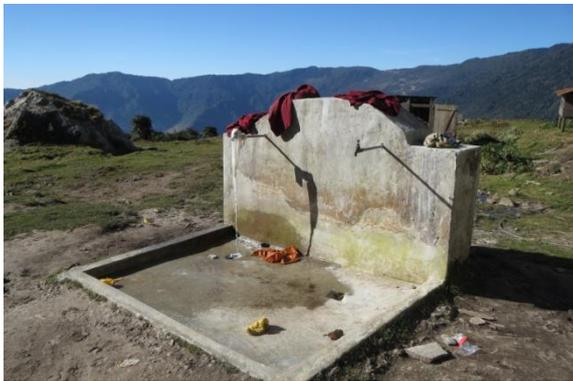
Sur cette photo ci-contre, c'est un point d'accès à l'eau à l'extérieur du monastère. Le joint du robinet n'est plus efficace, et l'eau s'écoule en permanence...
