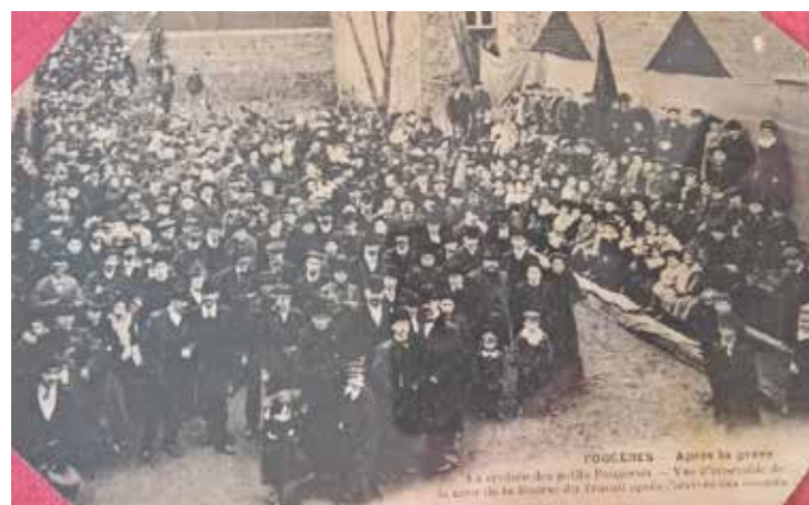
Vue d'ensemble de la cour de la Bourse du Travail après l'arrivée des enfants.
