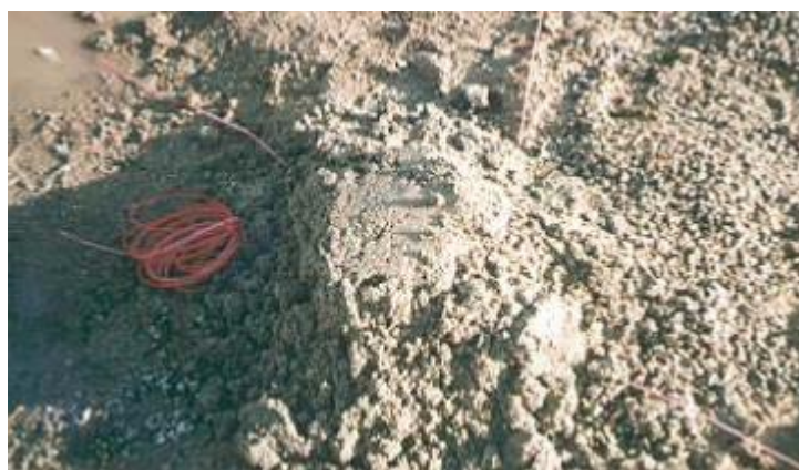
Figura 32: Conexiones enterradas en 20 cm de tierra o material de retacado
