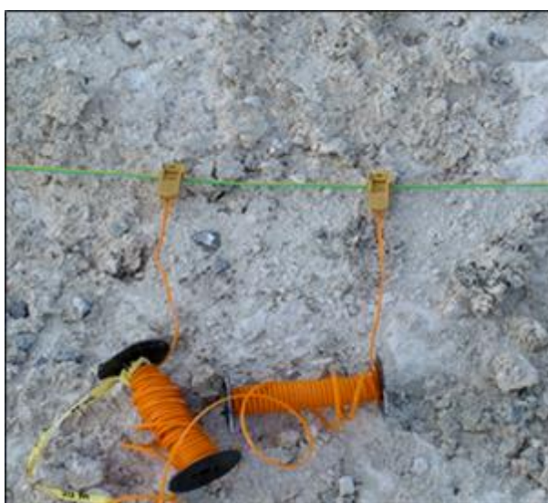
Figura 28: Conexión de detonadores electrónicos a la línea
