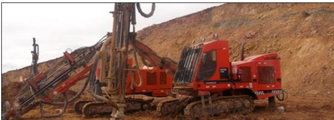
Figura 37: Carros de perforación para voladuras a cielo abierto
