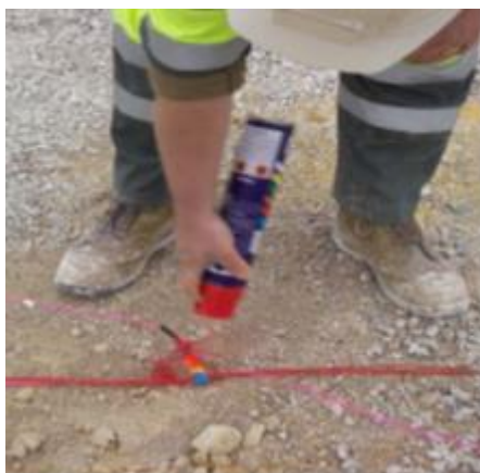
Figura 31: Marcado con espray de una conexión verificada
