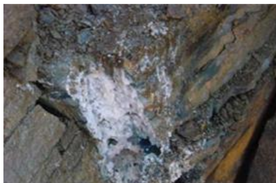
Figura 20: Columna de explosivo de un barreno fallido
