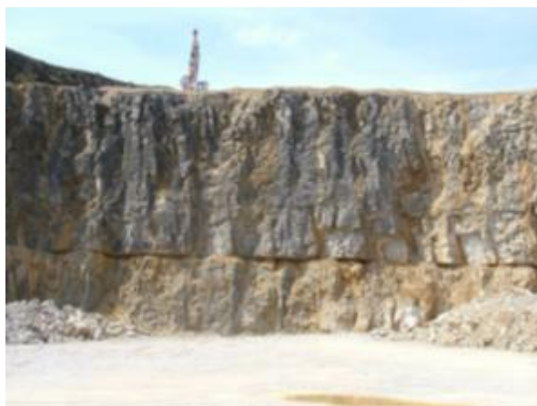
Figura 35: Presencia de planos horizontales de estratificación separando zonas de dureza variable
