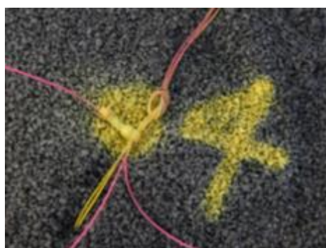
Figura 69: Barreno numerado con spray y conexión verificada
