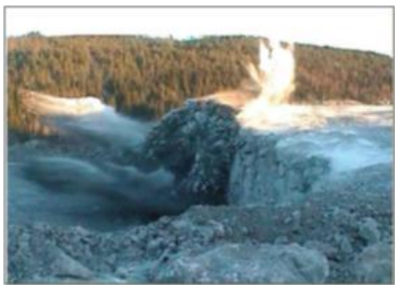
Figura 64: Proyecciones en una voladura en banco
