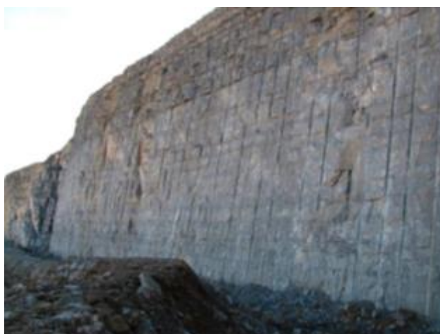
Figura 60: Talud final tras una pega de precorte
