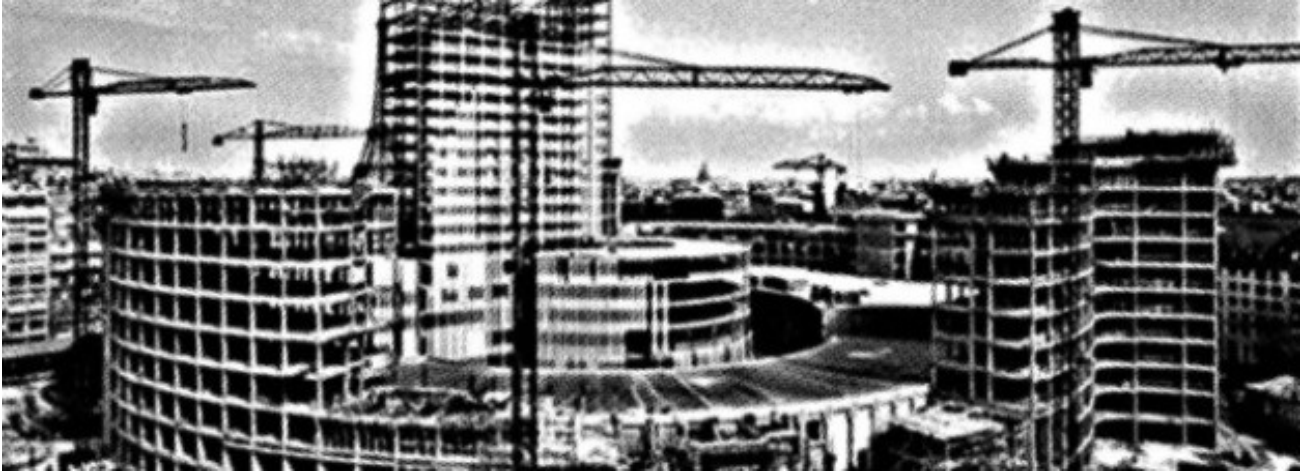
La construction de la maison de la radio
