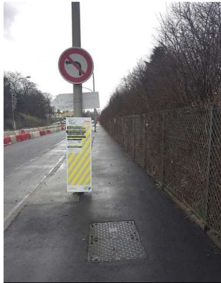
Panneau SGP annonçant les travaux
