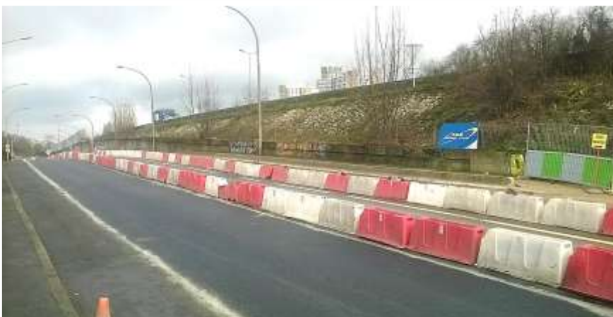
Travaux préparatoires de l'aménagement de la rue G.Péri
