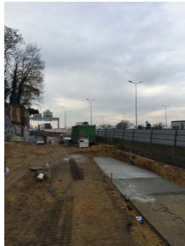
Jonction vers le passage sous A6
