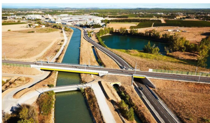
La ligne TGV franchissant le canal BRL à Vergèze
