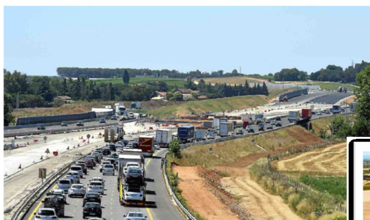
Les travaux de doublement de l'autoroute A9
