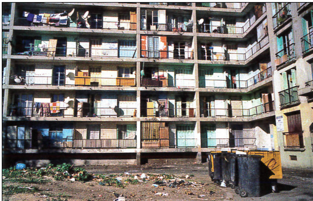
Doc. 1 : Un cadre de vie dégradé, photographie d'immeubles dans les quartiers Nord de Marseille (Bouches-du-Rhône).
