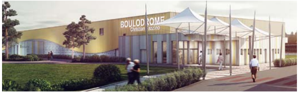
Les travaux du boulodrome Christian Fazzino se termineront fin mars 2015.
