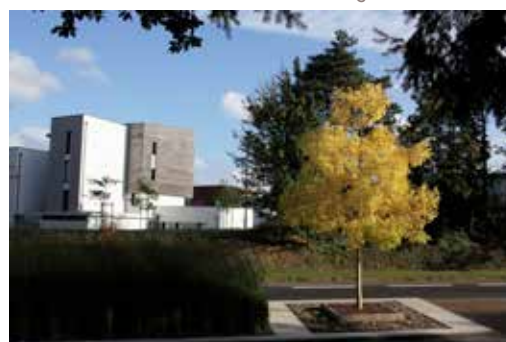
Nouveaux logements Picardie
