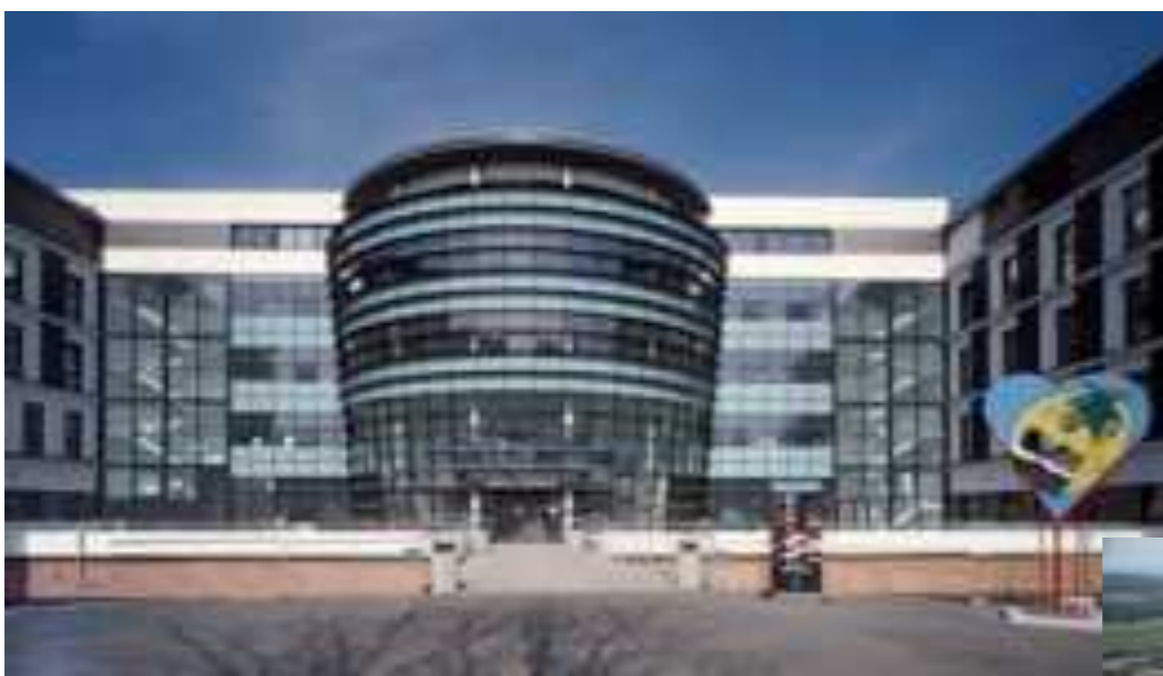
Hôpital René DUBOS à Pontoise
