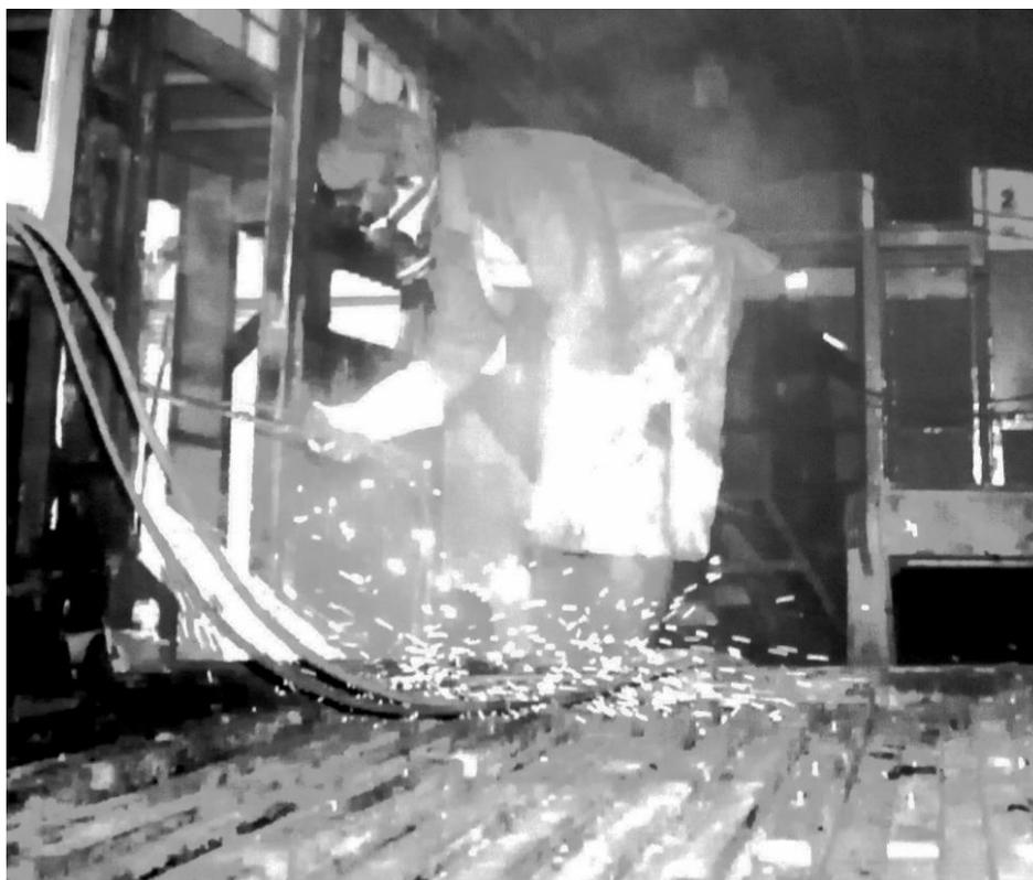
Découpage au chalumeau des structures d'un autorail pour enlever l'amiante
