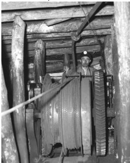
*Poste travail du fond exposant à l'amiante. Ce mineur conduit ce scraper durant tout son poste de travail. Il est positionné juste au-dessus de la bande de Ferodo amianté*
