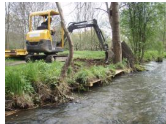
Création de sous berge
