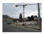
La dalle du RDC est coulée. L'élévation des murs du RDC débute.
