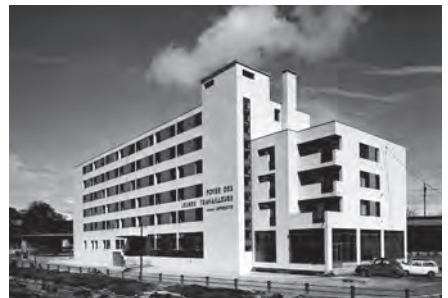
Foyer de jeunes travailleurs à Dijon situé rue Pont des tanneries, 1966, Archives nationales, 20140158/406, Union nationale pour l'habitat des jeunes.
