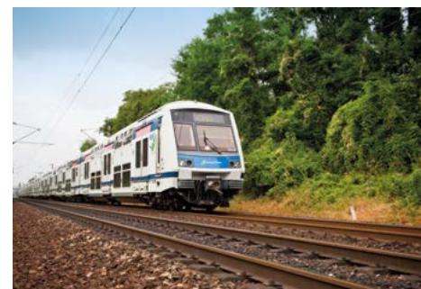
Voies du RER E à proximité de la future gare
