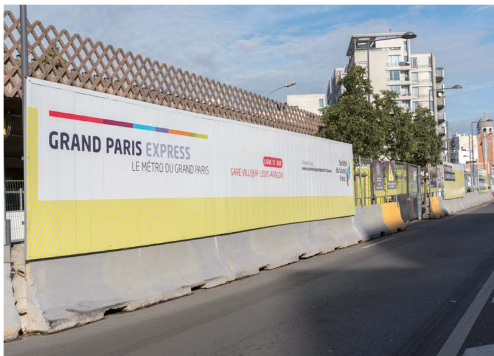
Exemple de panneaux d'information sur le site de la future gare de Villejuif Louis-Aragon
