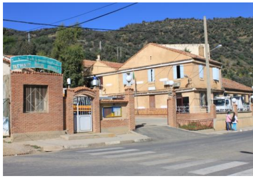
Ecole de Vieux Marché construite en 1893
